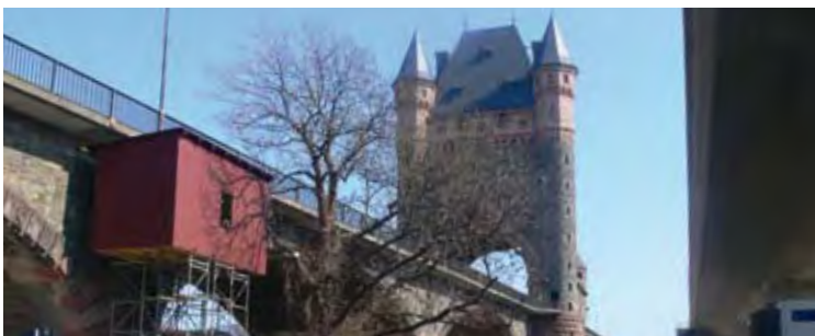
Angebrachtes Ersatzquartier an der Nibelungenbrücke
