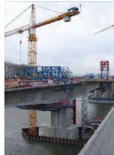
Bau der neuen Nibelungenbrücke
