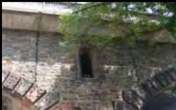
Einflugsöffnung des Fledermausquartiers in der Nibelungenbrücke
